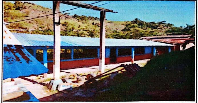
En esta imagen se observa la culminación del entechado con estructura de metal las tres aulas.
